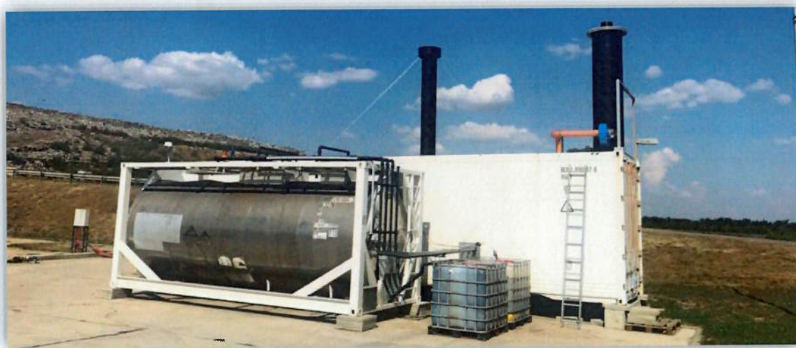
Figura 7 _Zona statie de epurare a levigatului
